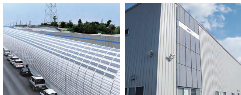
NEXCO西日本 120kW 高速道路遮音壁一体型 SST
