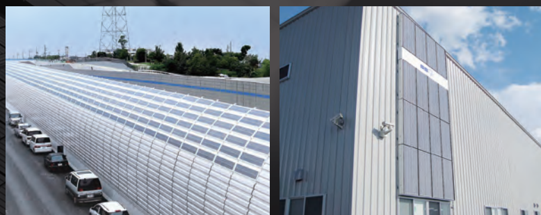
NEXCO西日本 120kW 高速道路遮音壁一体型
