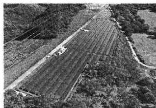
「加美ソーラーパーク」全景（提供：スマートソーラー）
