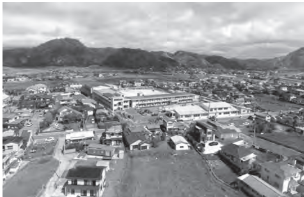
屋上に太陽光発電を搭載した鋸南小学校と近隣住宅 (スマートソーラーのリリースより)
