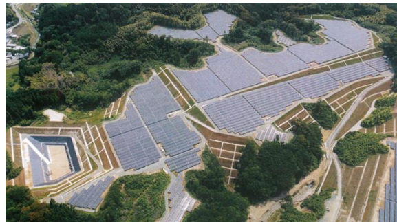
事例2)南向き固定の両面発電
